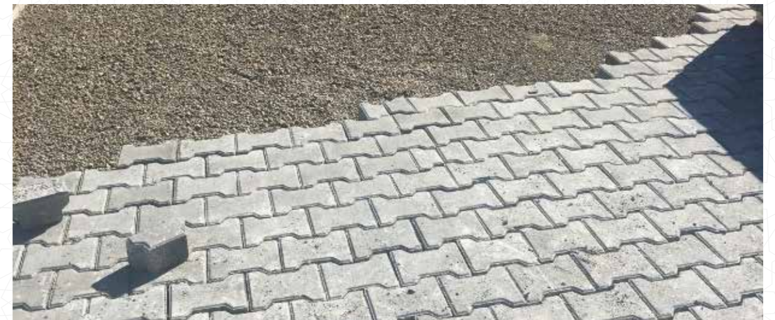
Kilimli Parke Taş Çalışmaları
