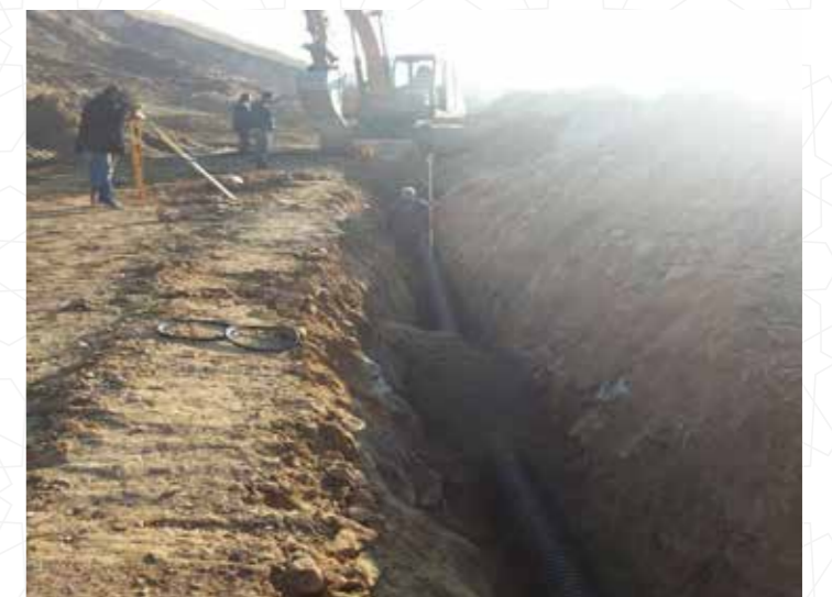
Kanalizasyon Şebeke Çalışması
