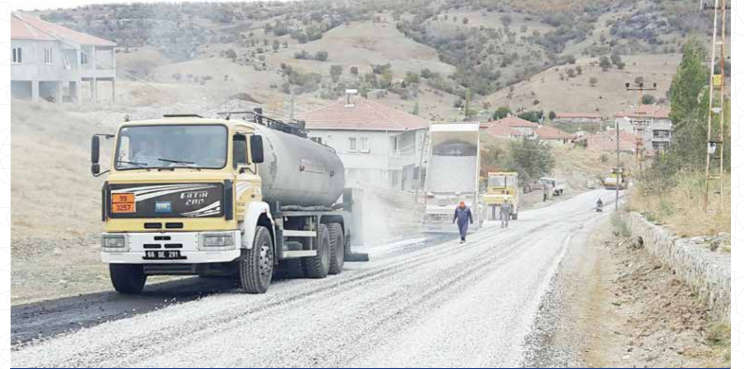
1. Kat Asfalt Çalışması
