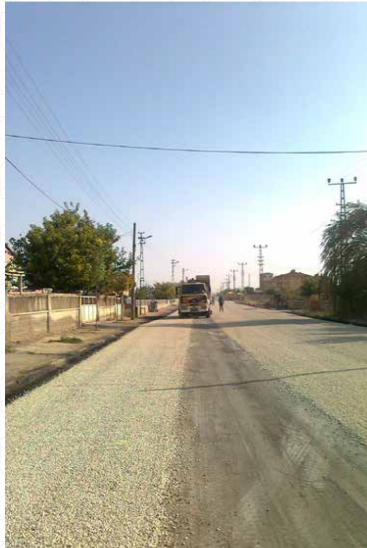
Asfalt Yol Yapım Çalışmaları
