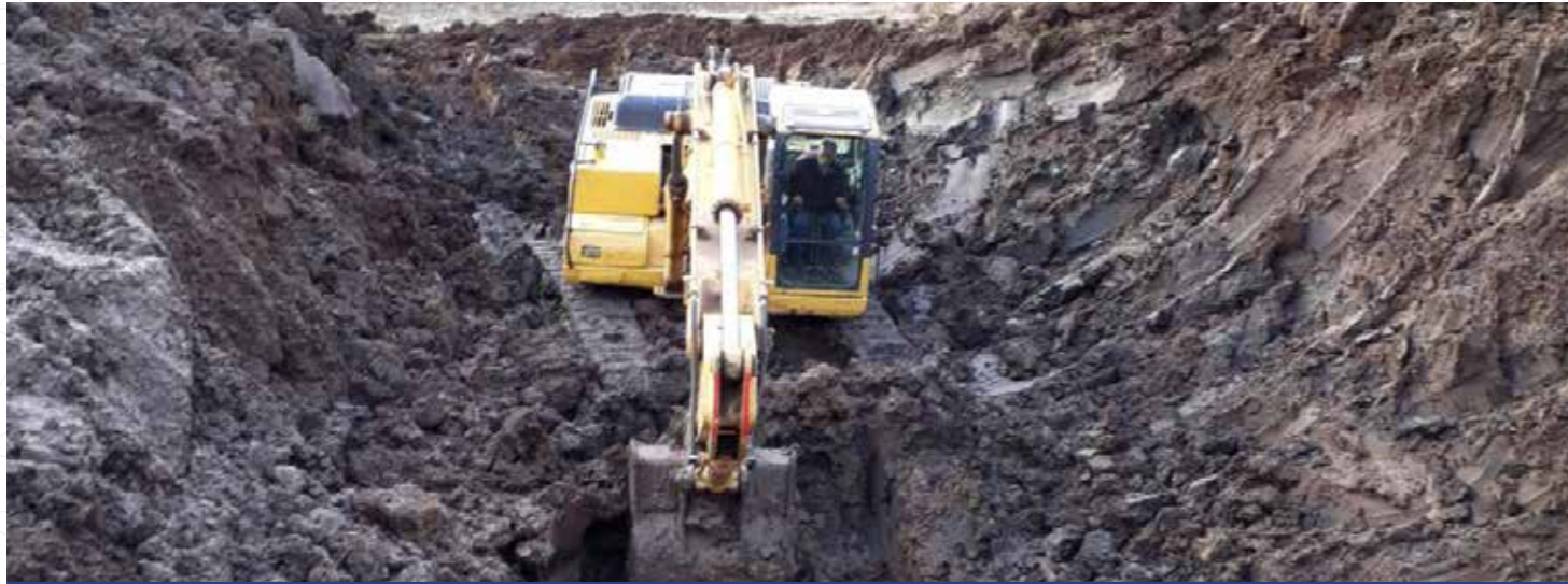
İçme Suyu Drainaj Çalışmaları
