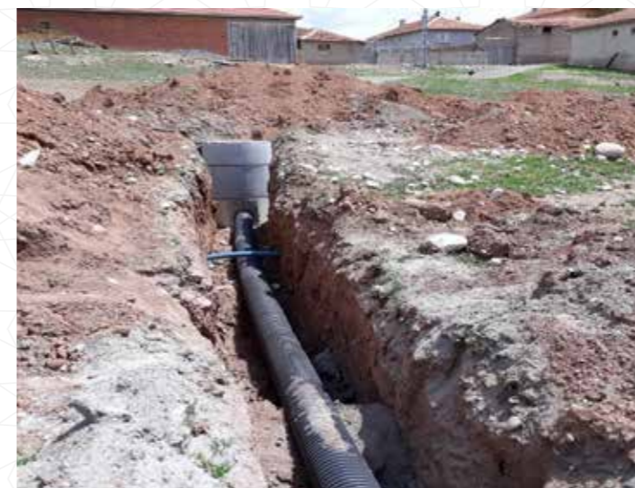
Kanalizasyon Şebeke Çalışması
