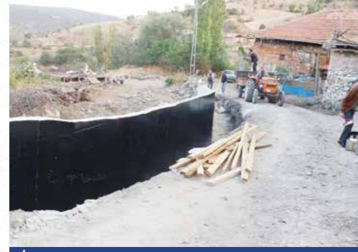
İstinat Duvarı Yapımı
