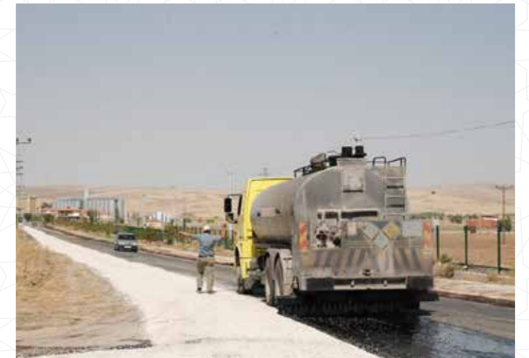
Yol Yapım Çalışması
