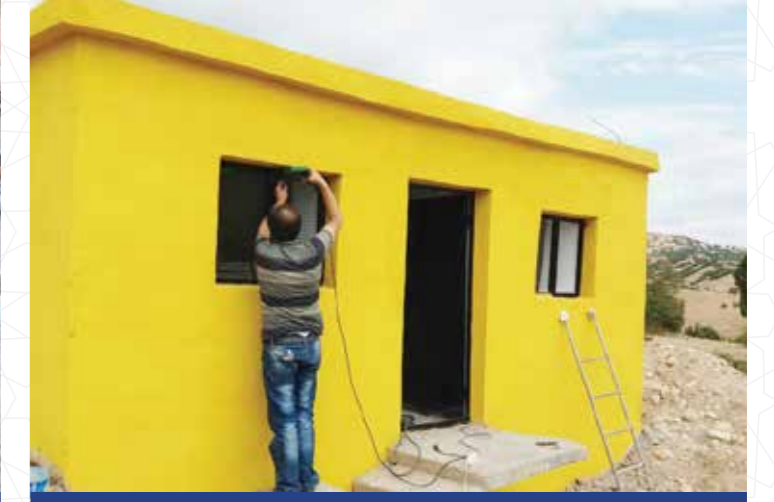
Su Depo Yapımı
