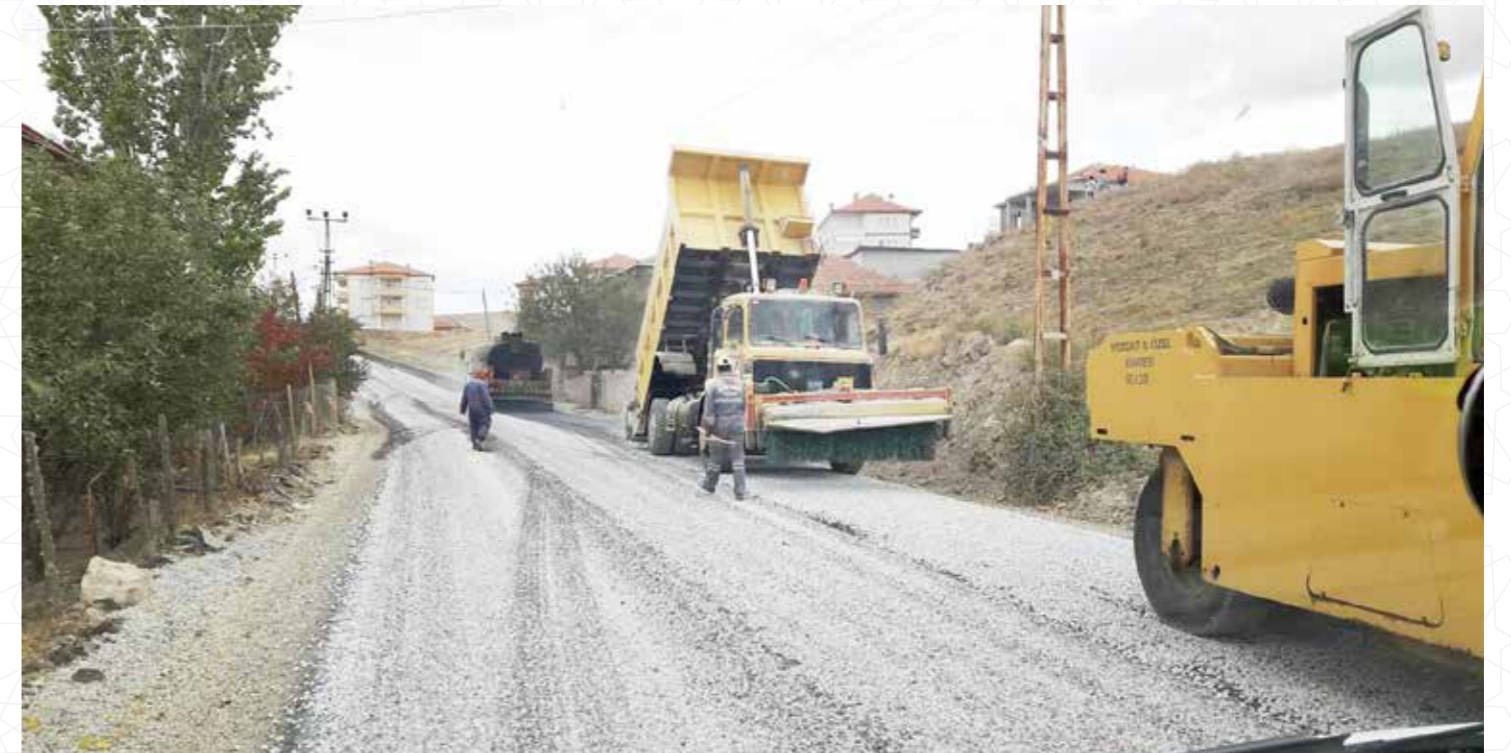
1. Kat Asfalt Çalışması
