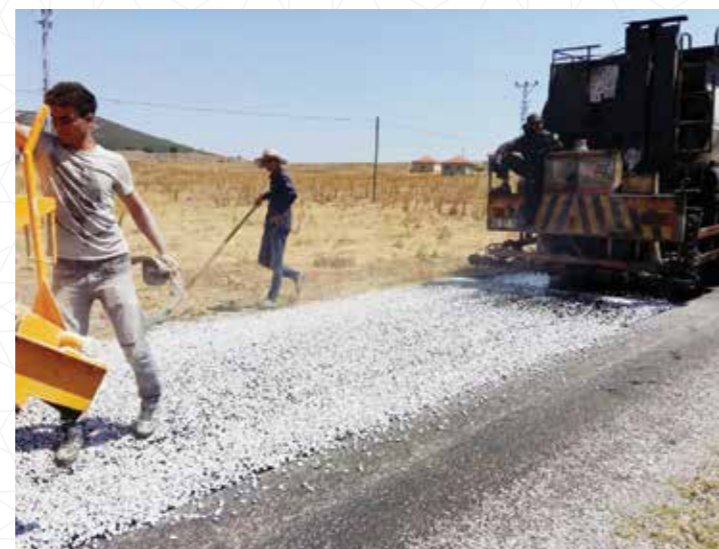
2. Kat Asfalt Çalışmaları
