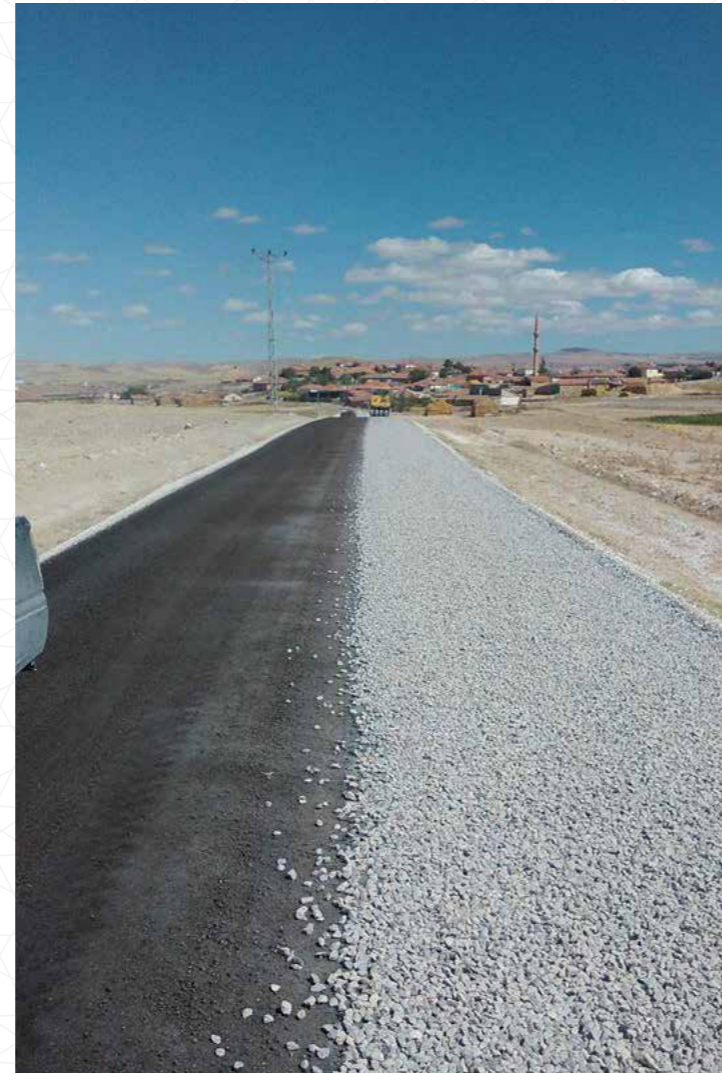
Asfalt Yol Yapım Çalışmaları
