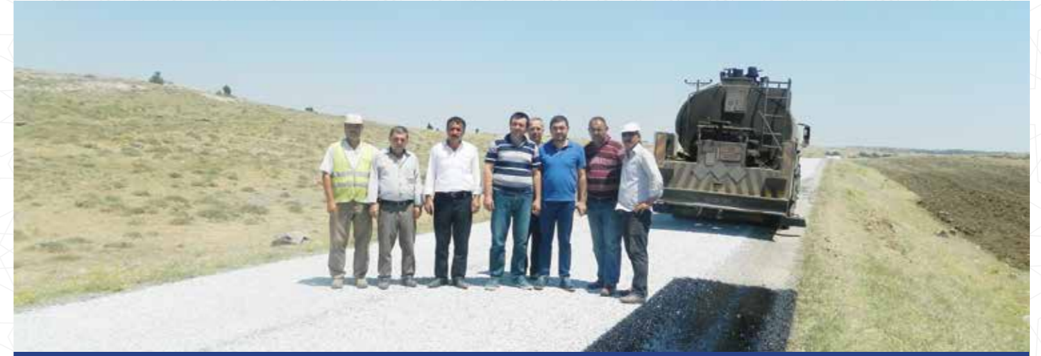
Asfalt Kaplama Çalışması
