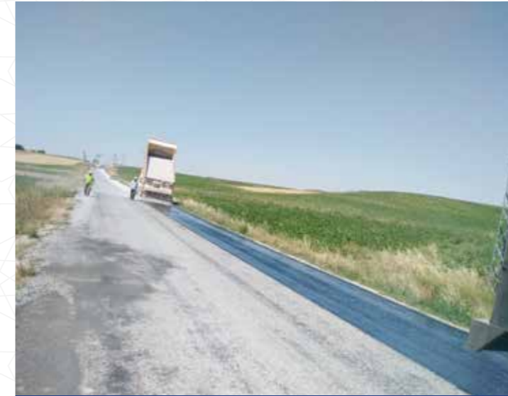
Yol Yapım Çalışmaları
