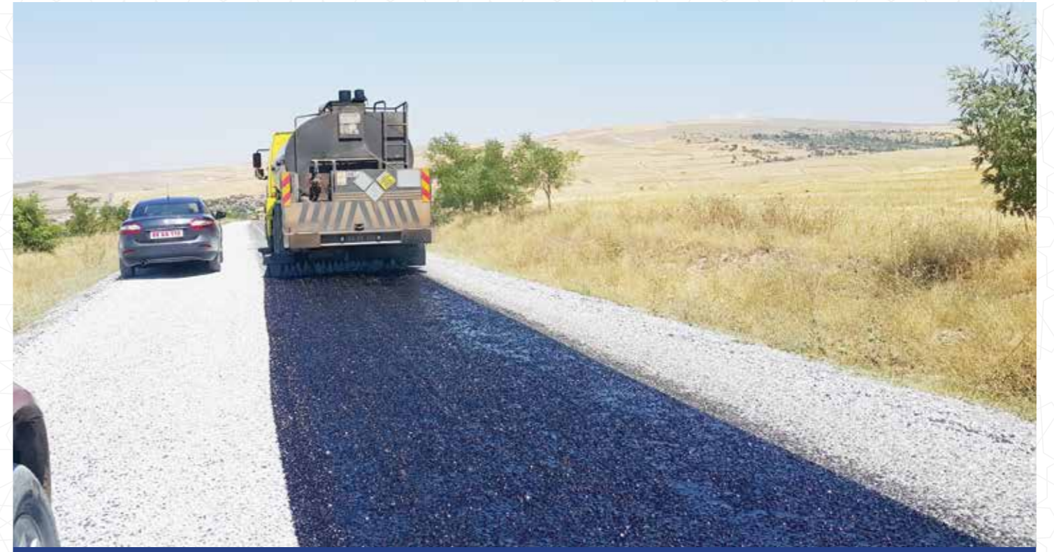
Yol Yapım Çalışmaları
